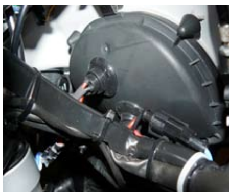
Eneste modifisering: Hull i lyktedeksel for gjennomføring av ledninger.
